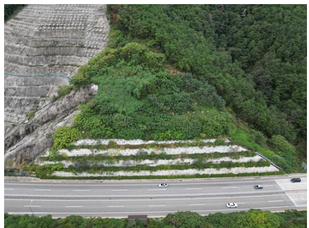
사면내 옹벽(패널식옹벽05) 전경
